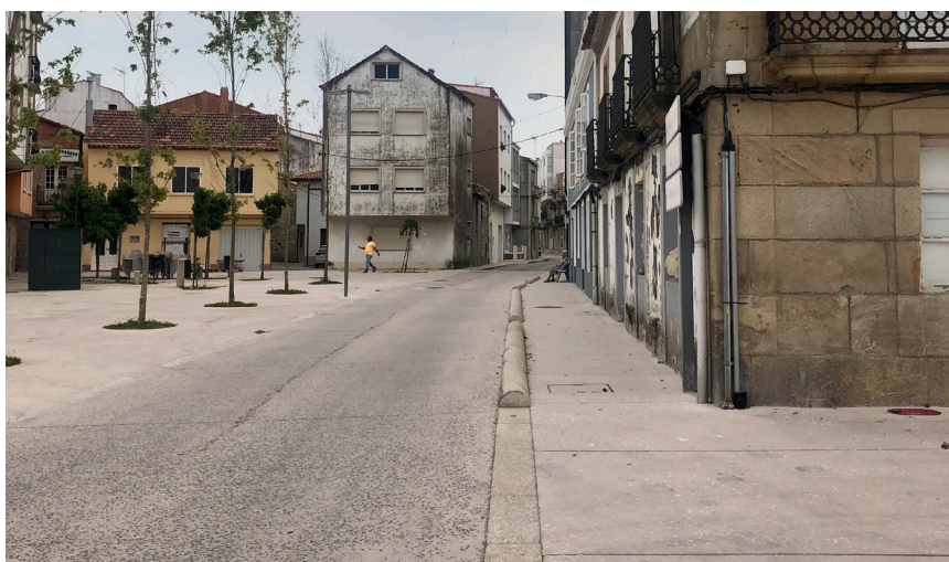
Unión entre dous tipos de formigón con áridos diferentes por un bordo de granito no fronte marítimo de Porto do Son, A Coruña.
