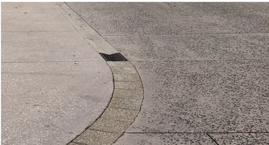
Bordo de granito con función de rigola, Porto do Son, A Coruña.
