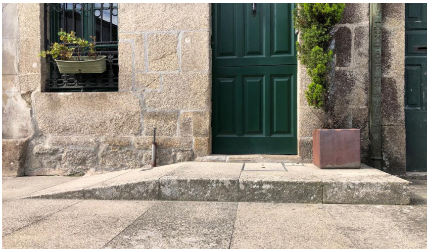
Rampla realizada para mellorar a accesibilidade a unha vivenda en Santiago de Compostela.
