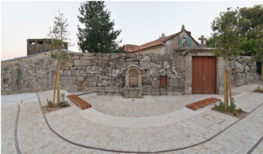
Fonte: Pavimento de adoquín de granito no Peto no Piñeiro en Gondomar, Adrián Capelo, 2020.
