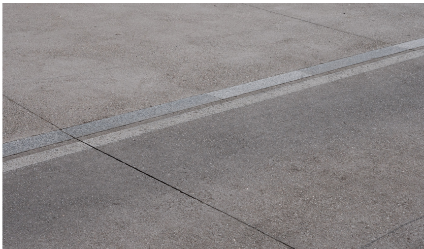
Pavimento de formigón desactivado, Santiago de Compostela.
