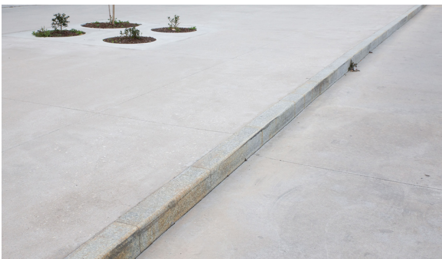
Pavimento de formigón sen árido visto, Santiago de Compostela.
