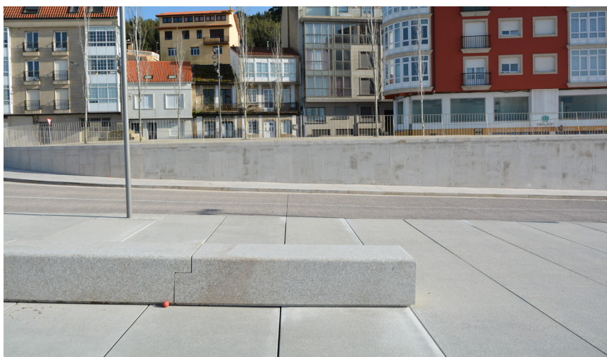
Pezas prefabricadas nunha beirarrúa de Porto do Son, A Coruña.
