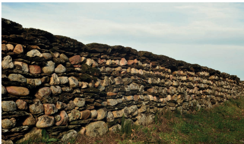
Fonte: Valado de cachotería en xunta seca (p.27), por Xunta de Galicia, 2017, Guía de Caracterización e Integración Paisaxística de Valados.
