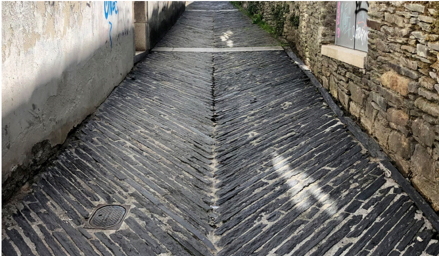
Pavimento de lousas con colocación vertical no casco antigo de Lugo.
