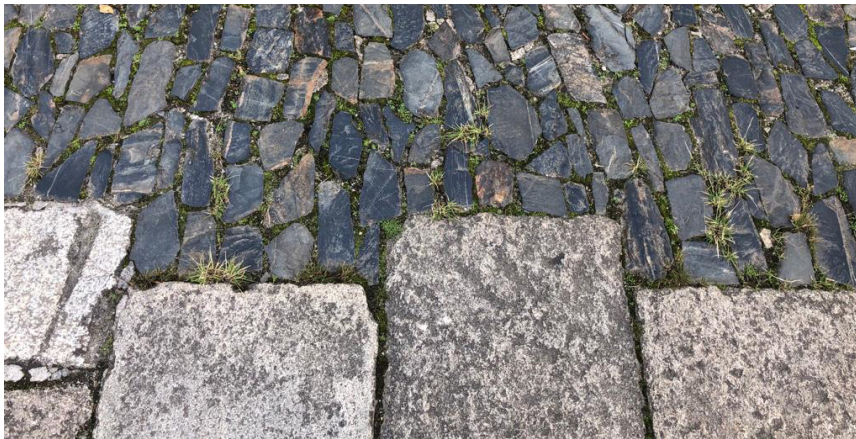
Unión entre pavimento de lousas e pezas de granito na contorna da Colexiata do Sar en Santiago de Compostela.
