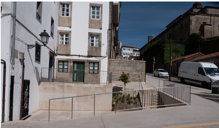
Iluminación en fachada na Rúa Castrón Douro, Santiago de Compostela.
