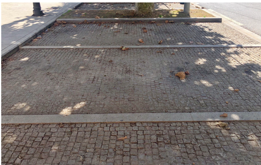
Adoquín de granito empregado para unha zona de aparcamentos en Lugo, servindo ao mesmo tempo como superficie filtrante.
