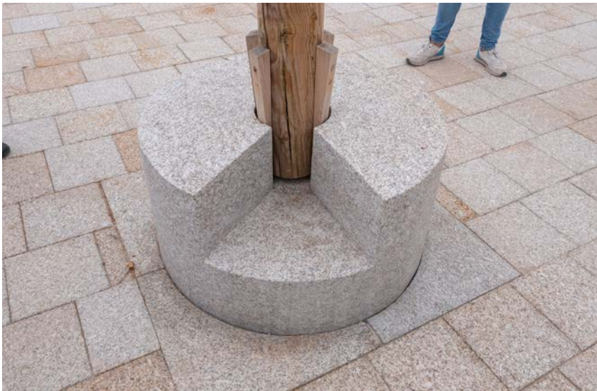
Unión de lousas de granito con elemento de apoio da estrutura de madeira no fronte marítimo de Porto do Son, A Coruña.
