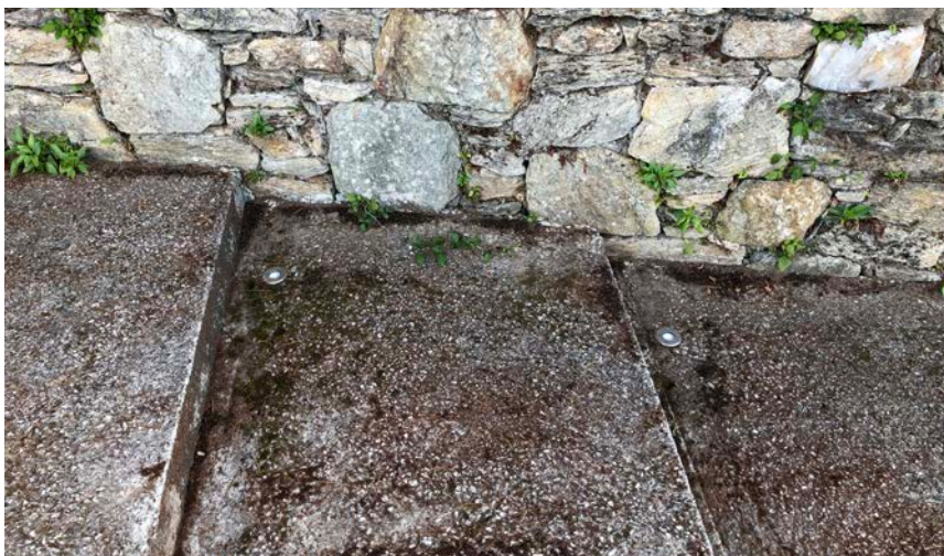
Iluminación no plano do chan, situado nas escaleiras das hortas de Caramoña en Santiago de Compostela.
