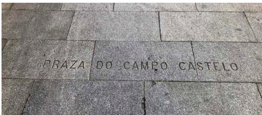
Identificación de espazos mediante o rebaixe no granito do pavimento na Praza do Campo Castelo en Lugo.
