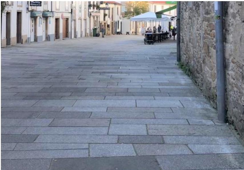
Pavimento de lousas de granito na Rúa Carretas en Santiago de Compostela.
