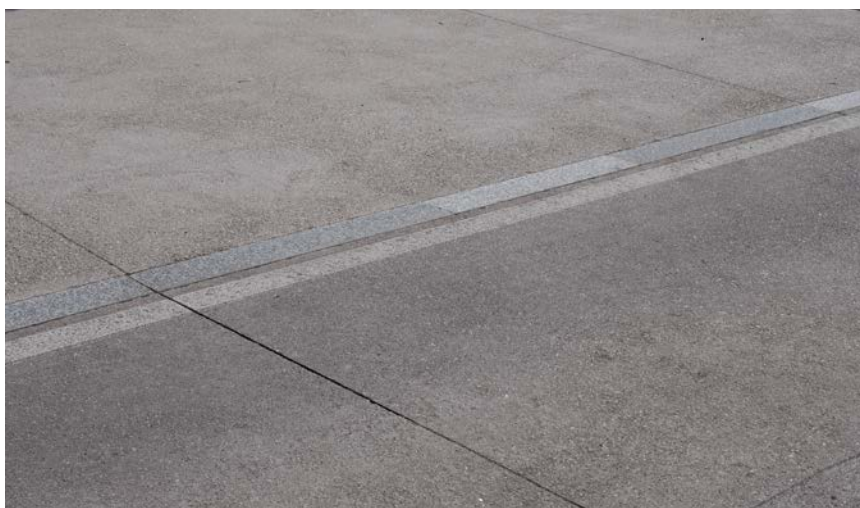
Unión entre dous tipos de formigón sen áridos visto, con dúas tonalidades diferentes separados por un bordo de granito en Castrón Douro, Santiago de Compostela.
