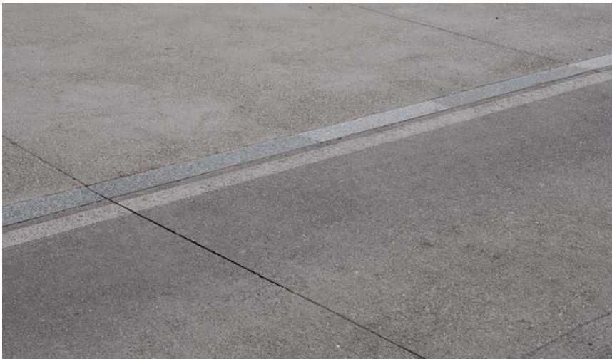
Pavimento de formigón desactivado, Santiago de Compostela.
