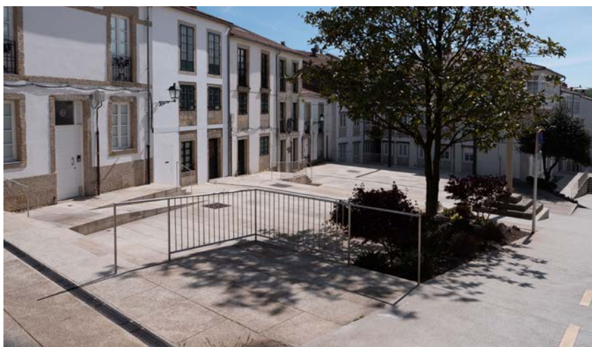
Varanda de protección entre desniveis na Rúa Castrón Douro, Santiago de Compostela.
