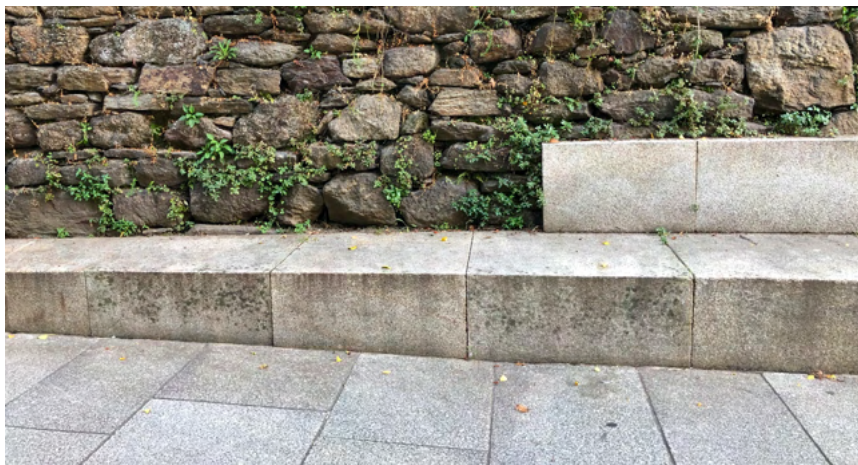
Unión entre pavimento e muro con un banco de granito na Rúa da Trindade en Santiago de Compostela.
