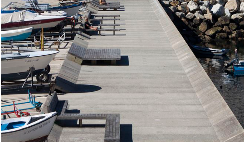
Pavimento de lousas prefabricadas de formigón no Porto de Malpica, A Coruña
