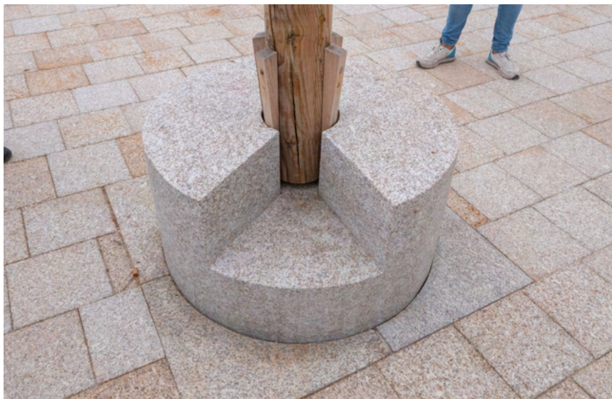
Unión de lousas de granito con elemento de apoio da estrutura de madeira no fronte marítimo de Porto do Son, A Coruña.
