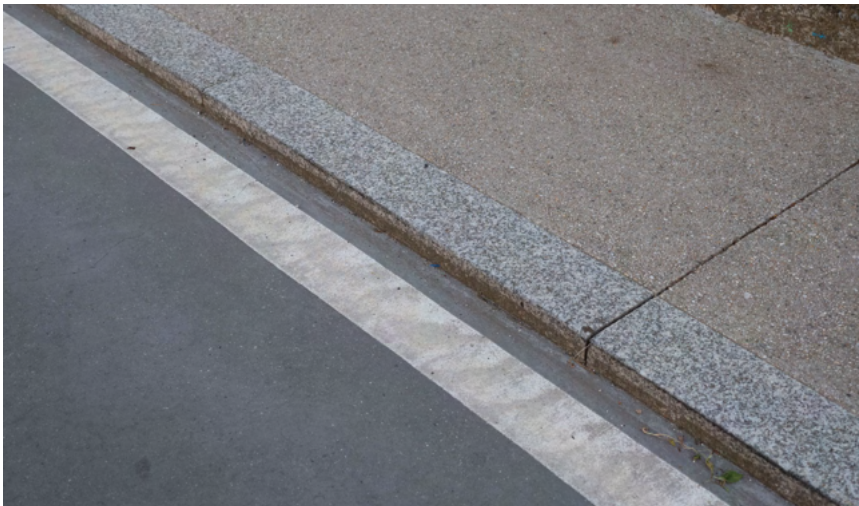
Unión entre formigón e asfalto mediante un bordo de granito en Castrón Douro, Santiago de Compostela.
