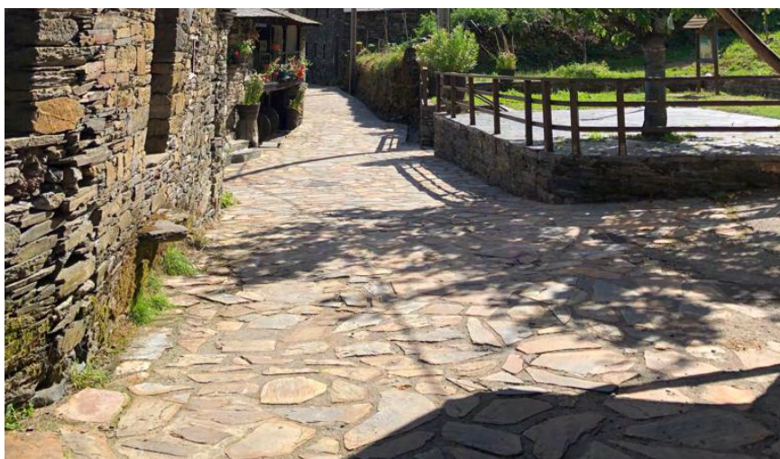
Pavimento de lousa colocadas horizontalmente na aldea da Seara en Quiroga, Lugo.
