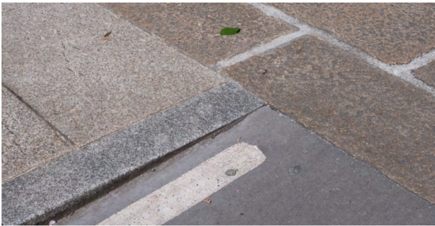
Unión entre granito, bordo e formigón homoxéneo de cor escura na Rúa Castrón Douro en Santiago de Compostela.
