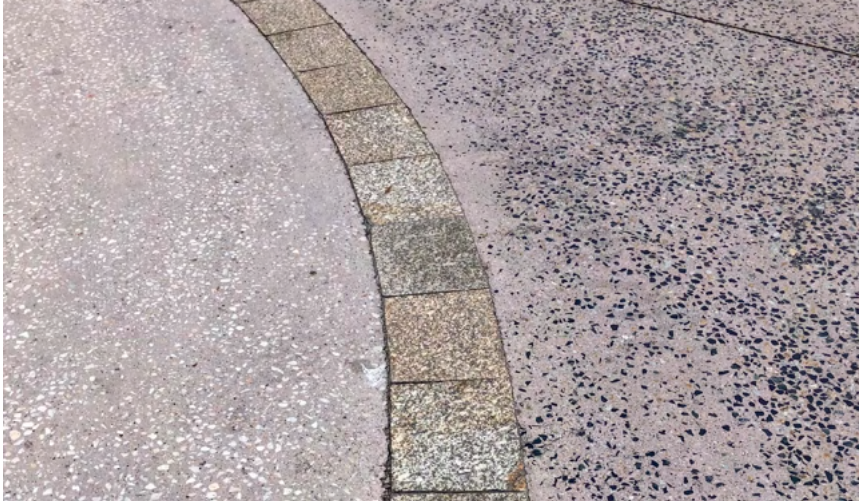
Pavimento de formigón- Dúas tonalidades de árido(clara e escura), Porto do Son, A Coruña.
