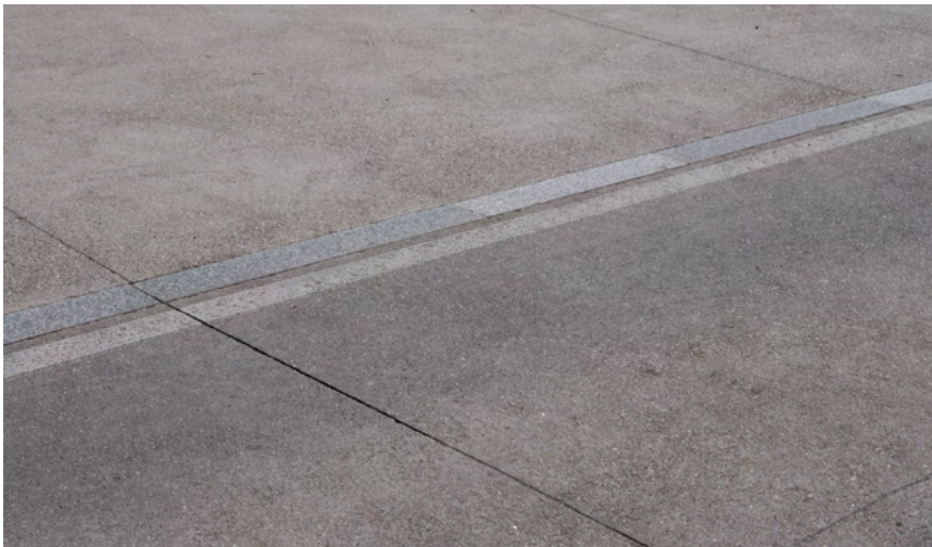
Pavimento de formigón desactivado, Santiago de Compostela.
