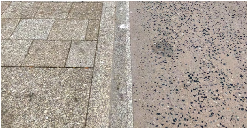
Unión entre granito e formigón con árido visto no bordo marítimo de Porto do Son, A Coruña.
