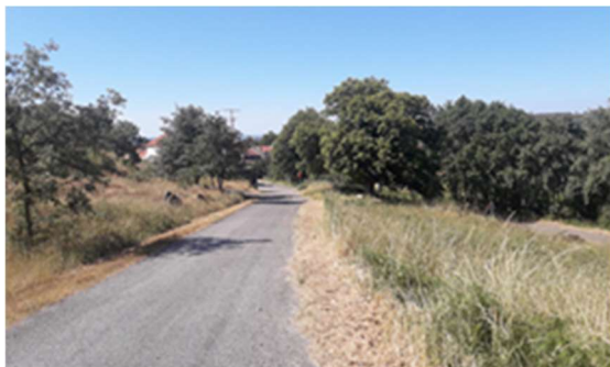
Estrada acceso a aldea
