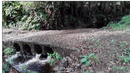
Ponte situada no interior do perímetro
