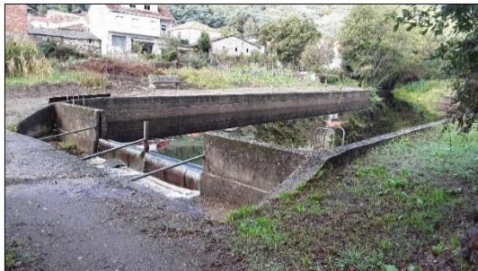
Presa situada no límite leste do perímetro
