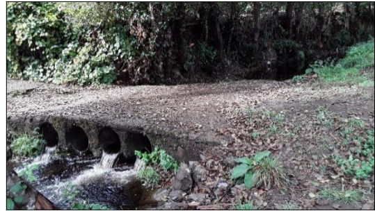
Ponte situada no interior do perímetro
