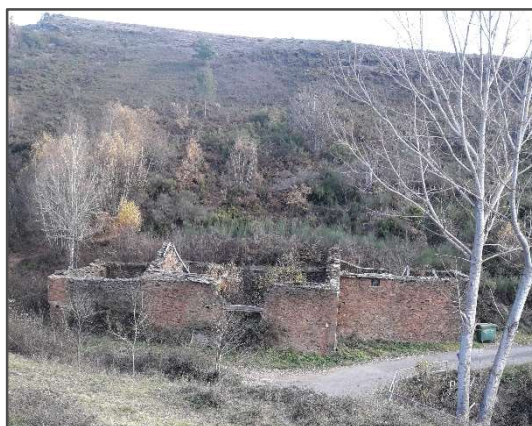
Construción tradicional en abandono.
